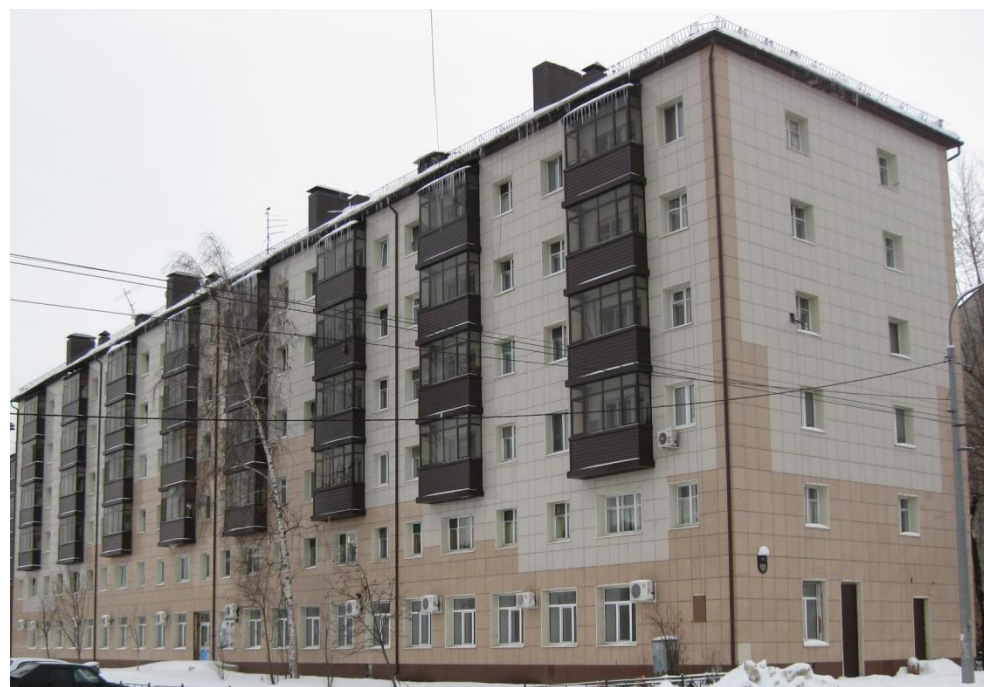
Рис.1. Фотоснимки жилых домов по ул. Ташаяк, г.Казани: слева – до кап. ремонта, справа – после кап. ремонта с устройством навесного фасада.
